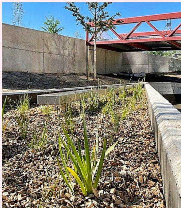
Zanjas de drenaje instaladas por FieldFactors en el Parque Caleido (Madrid) para reutilizar el agua de lluvia.
